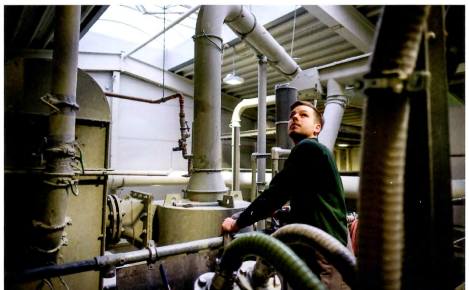
Der Recyclingprozess bei MPM läuft fast vollautomatisch ab. Dieser Mitarbeiter kontrolliert den Ablauf an einer Anlage, in der das Bohr- und Fräsmehl gewässert wird, um das enthaltene Kupfer vom Kunststoff zu trennen.
